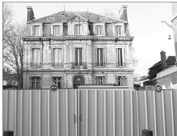
L'ancienne propriété qui accueillait la Poste est en cours de rénovation afin d'accueillir à l'avenir une étude notariale.
